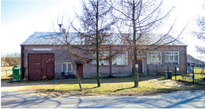
Świetlica Borki Kosiorki przed remontem
